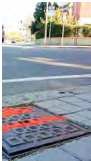
Cantiere per la fibra ottica
